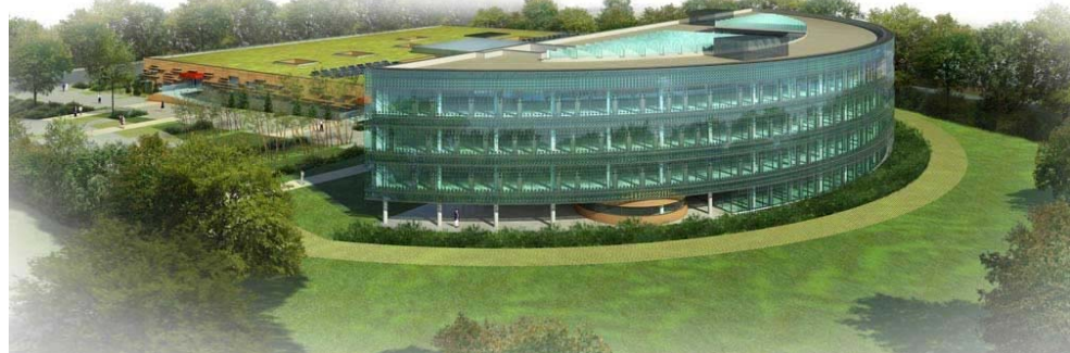
Réalisation ARCOM CVL
